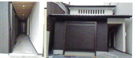
「新町家」の施工事例
